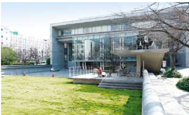
SAKURA CENTER#14（14号館） 創立75周年記念事業の一環として、教育環境の改善充実を図る目的で2004年3月に竣工。アリーナ（体育館）のほか、学生食堂、カフェテリア、トレーニングルーム、武道場などさまざまな機能を併せ持つ複合施設。
